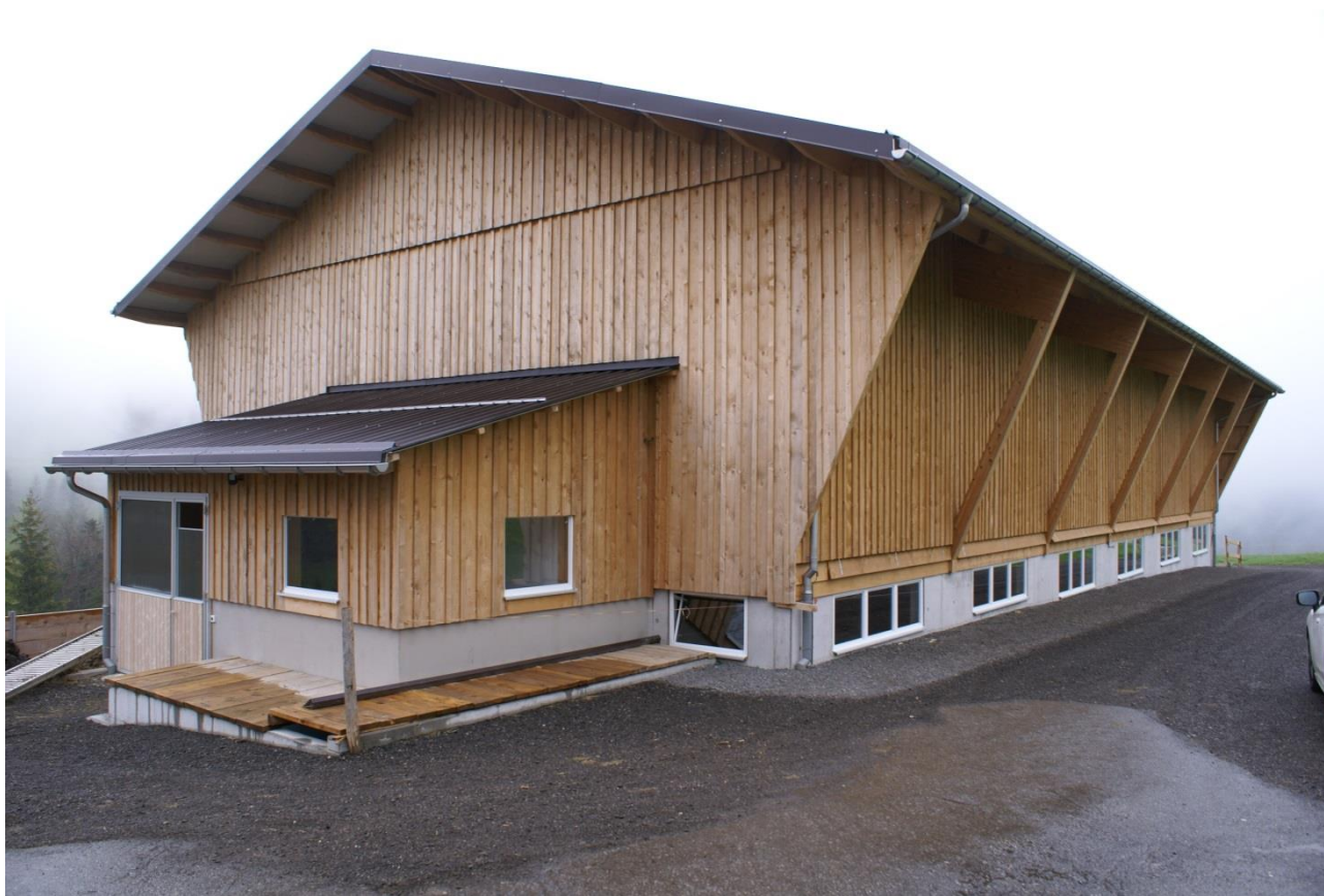
Neubau Anbindestall, Schwellbrunn
