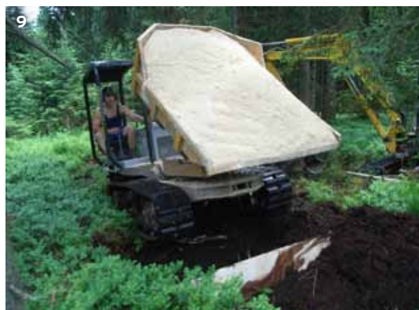
9 Hochmoorregeneration durch Einstauung alter Entwässerungsgräben und Auffüllung mit Sägemehl, Hochmoor Bruggerenwald (Urnäsch).
