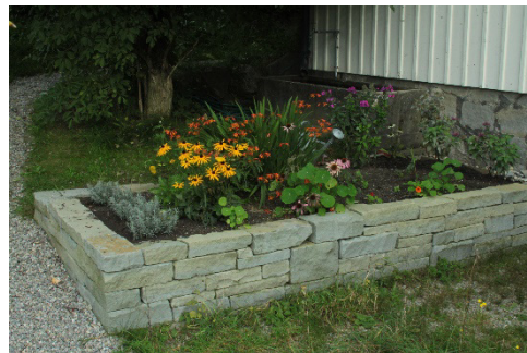
Abbildung 2: Trockenmauer als Abgrenzung für Blumenbeet. (Foto: ARNAL AG)
