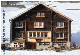
Tätschdachhaus in Gais
