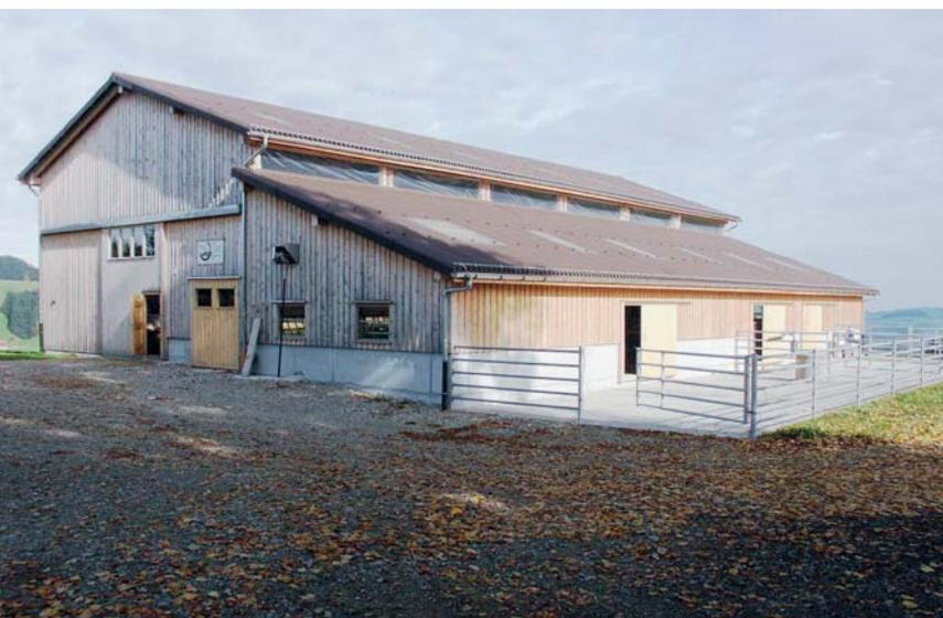
Der einfache Baukörper wurde mit einem gleichschenkligen Satteldach und kurzen Überständen versehen.
