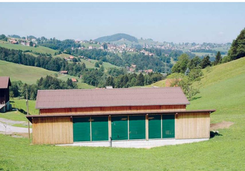
Die Fassade auf der Südseite des Stalls ist mit grossen Öffnungen neben geschlossenen Wandteilen versehen. Die Gebäudeecken sind als geschlossene Fassadenteile auszubilden.
