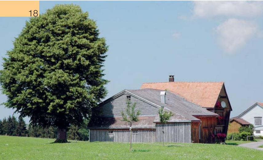
Das unbehandelte Holz an der Aussenfassade des Hofes wurde der Witterung ausgesetzt und erhält eine natürliche Patina. Das Holz auf der Wetterseite erhielt einen silbrigen Farbton, auf der dem Wetter abgewendeten Seite behielt es seinen braunen Farbton.
