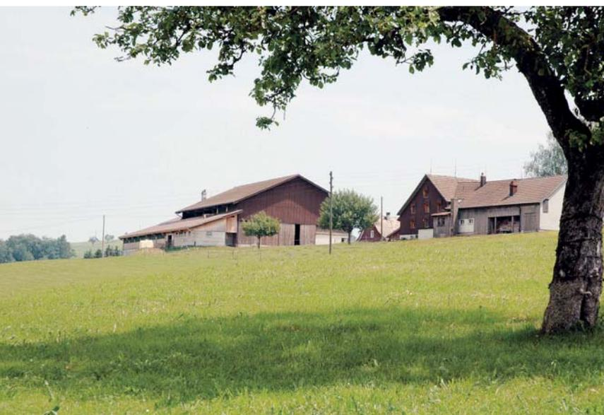
Der First des Anbaus ist von der Traufe des Hauptdachs abgesetzt, wodurch die Erweiterung ablesbar wird. Die Übernahme der gleichen Dachneigung verstärkt das harmonische Bild zwischen Alt- und Neubau.
