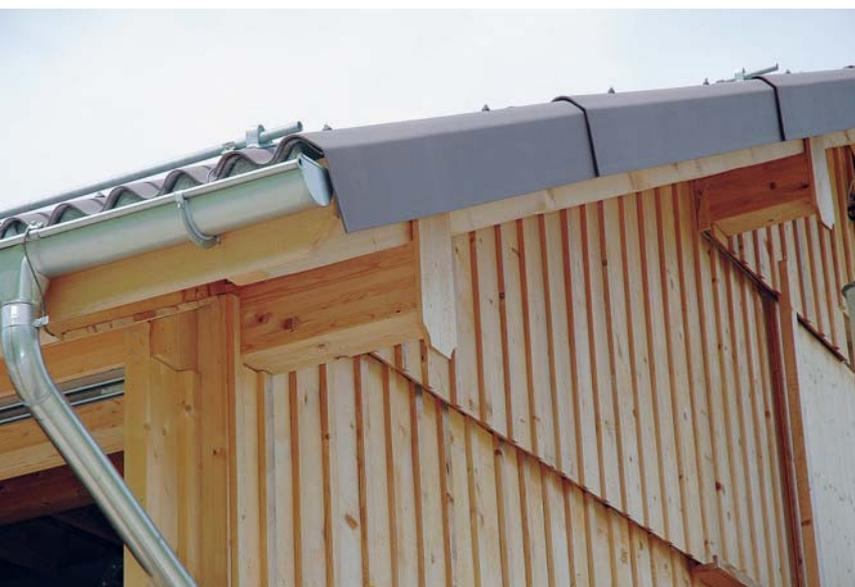
Ein mit Leistenschirm verkleideter Stall. An den Kopfenden der Pfetten sind Stirnhölzer als konstruktiver Schutz angebracht.
