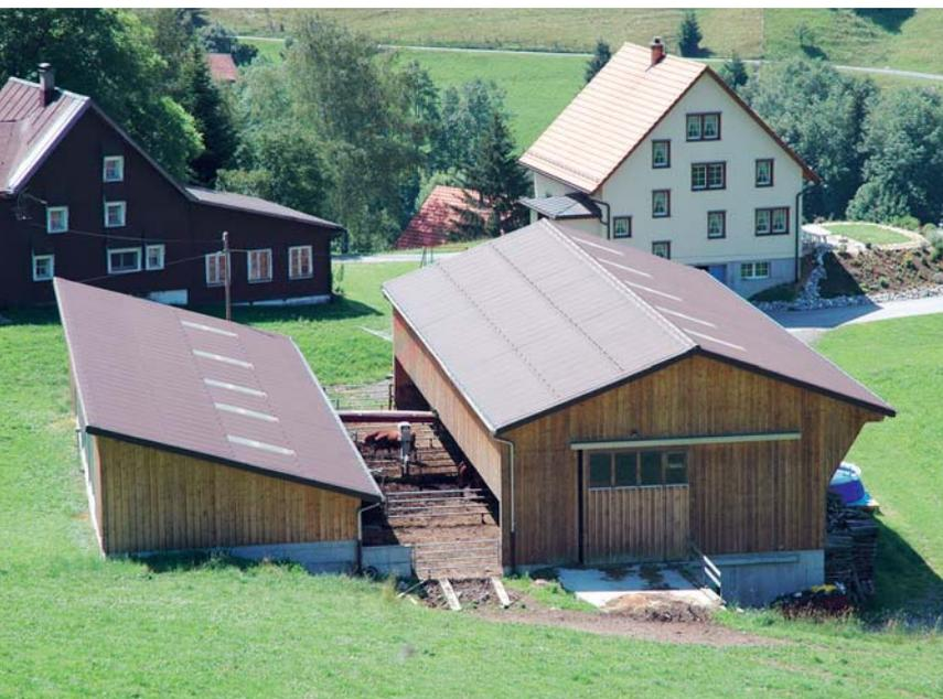
Als herkömmliches und ansprechendes Material für die Dacheindeckung haben sich Tonziegel bewährt. Nicht an das Wohnhaus angebaute Ökonomiebauten sind auch mit Wellplatten oder Ziegeln aus Faserzement bewilligungsfähig.
