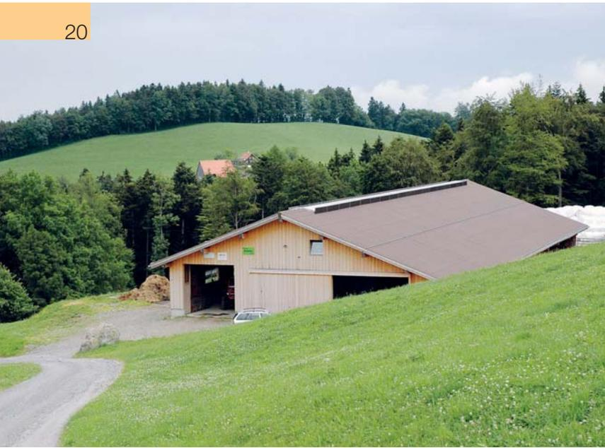
Der Stall wird über einen Lichtfirst belichtet, wodurch die Dachfläche von weiteren Öffnungen oder lichtdurchlässigen Elementen freigehalten wird.
