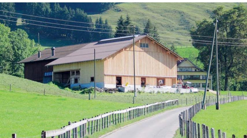
Der Anbau ist mit der gleichen Dachform und -neigung des Bestands gedeckt. Durch die grössere Gebäudebereite setzt er sich vom bestehenden Gebäudeteil ab.
