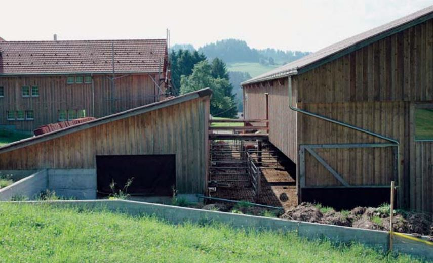
Der Laufhof wurde zwischen dem Laufstall und dem Futtertisch platziert, es ergibt sich ein Zwischenraum. Durch die Fortsetzung des gleichen Dachs vom Hauptgebäude auf dem kleineren Gebäudeteil bilden die Baukörper eine Einheit.
