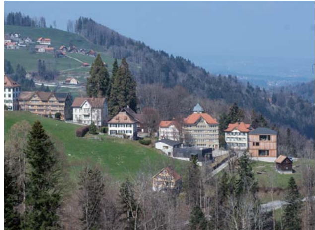
Der Neubau rechts fügt sich bezüglich Grösse und Stellung gut in die bestehende Situation ein.
