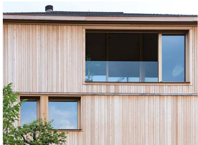
Loggien mit geschlossener Brüstung verringern die Lärmbelastung für dahinter liegende Wohnräume stark.
