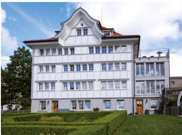
Der moderne Anbau setzt die Fassadengliederung fort und bewirkt damit ein stimmiges Weiterbauen am Bestand.
