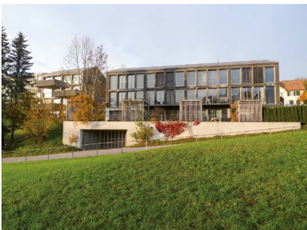
Die Tiefgarage passt sich gut ins Gelände ein. Für die Einfahrt sind keine Ausgrabungen nötig.
