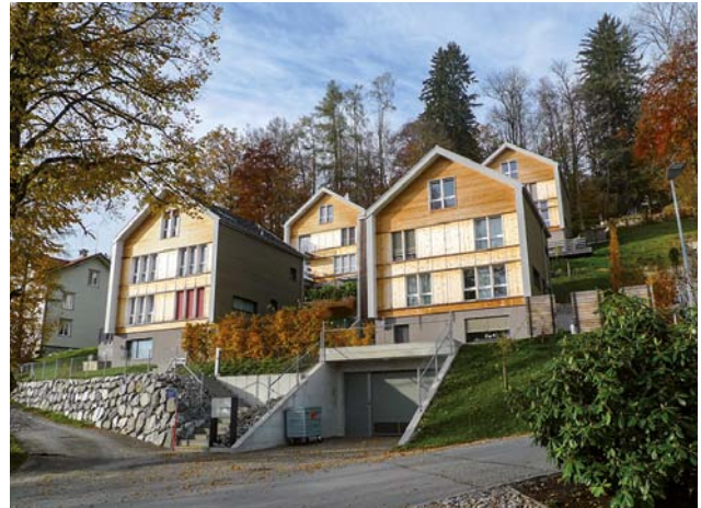
Die Stützmauern beschränken sich auf den Bereich der Garageneinfahrt.
