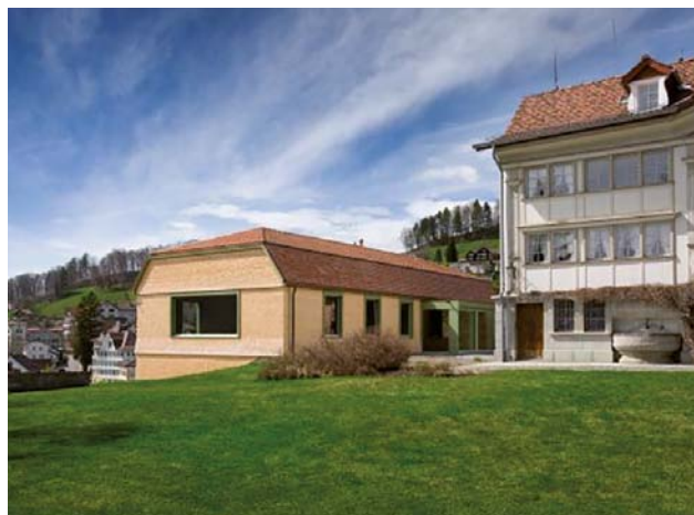
Gleiche Materialisierung des Daches schafft eine selbstverständliche Verbindung von Alt- und Neubau.
