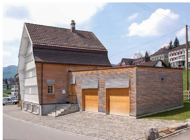
Der Neubau passt sich dem Altbau durch geschickt eingesetzte traditionelle Elemente hervorragend an.
