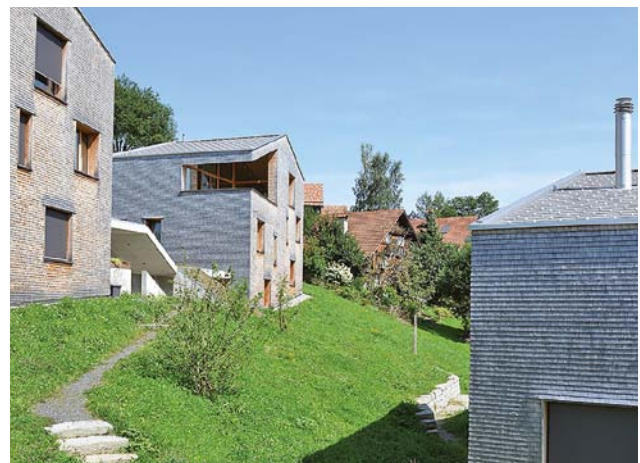
Der Freiraum zwischen den Gebäuden bleibt im natürlichen Geländeverlauf.
