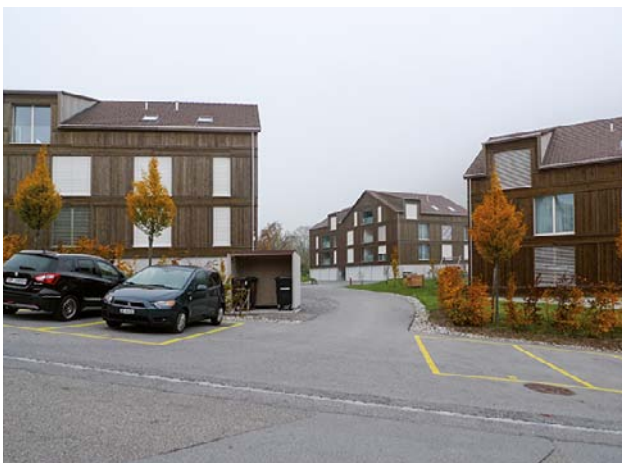
Geschickt geplante Mehrfamilienhäuser erreichen auch mit nur zwei Vollgeschossen bereits eine überdurchschnittliche Dichte.
