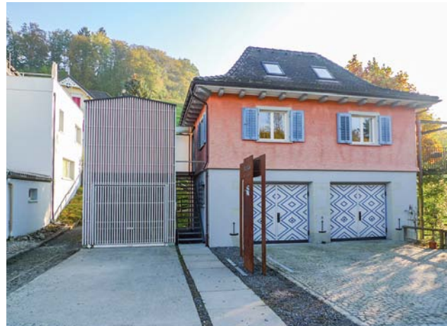
Der Garagenanbau passt sich dem Bestand gut an.
