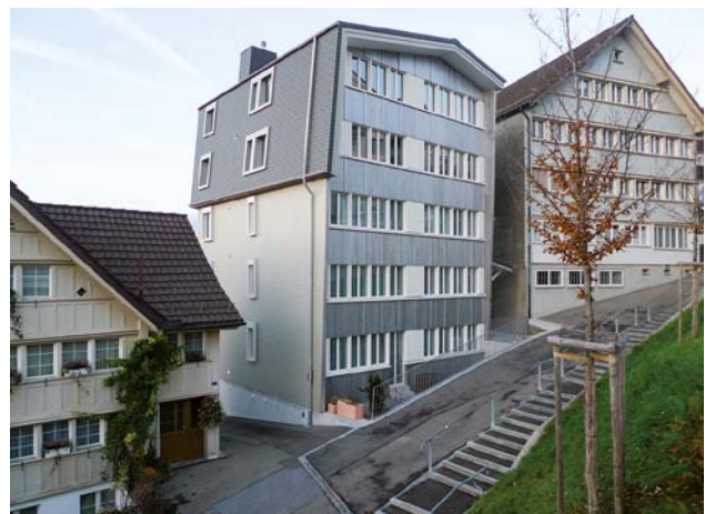
Der Neubau ist zwar höher als das bestehende Gebäude rechts, ordnet sich aber wegen der Hanglage ein.
