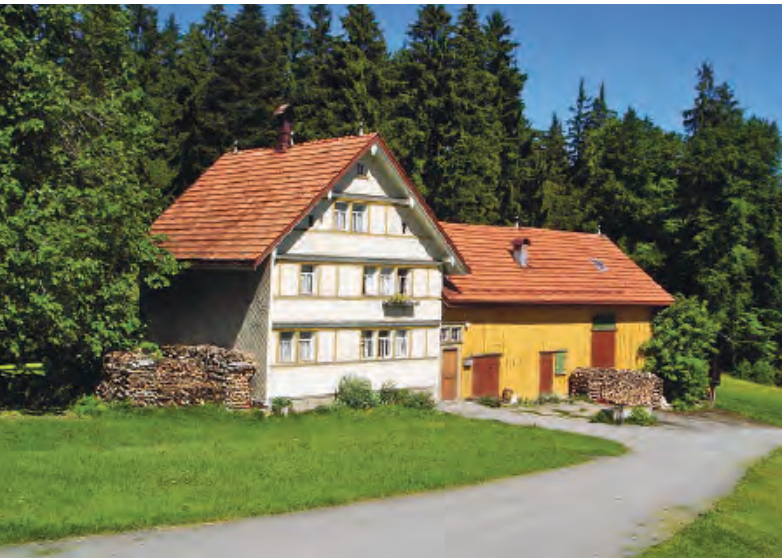
Abb. 2: Appenzeller Hausbegleiter: Links der Wetterbaum und Holzbeige, ein Strussgstell (Blumenbrett) unter dem Schlafzimmer, ein vorgelagerter Hausplatz mit Brunnen und ein Holderstrauch rechts der Scheune.
