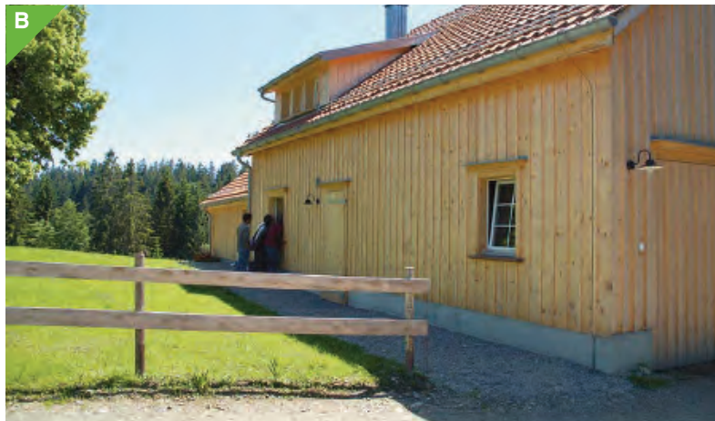
Abb. 16: Ein schmaler Gehweg aus Kies führt zum Hauseingang.
