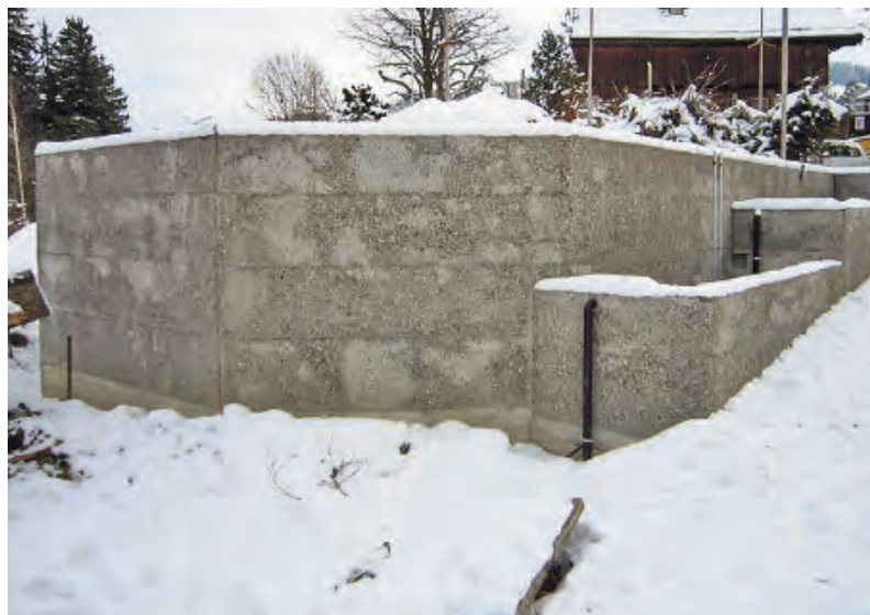
Abb. 9: Massiver Eingriff in die bestehende Topografie zugunsten eines ebenen Gartenplateaus in der Landwirtschaftszone.
