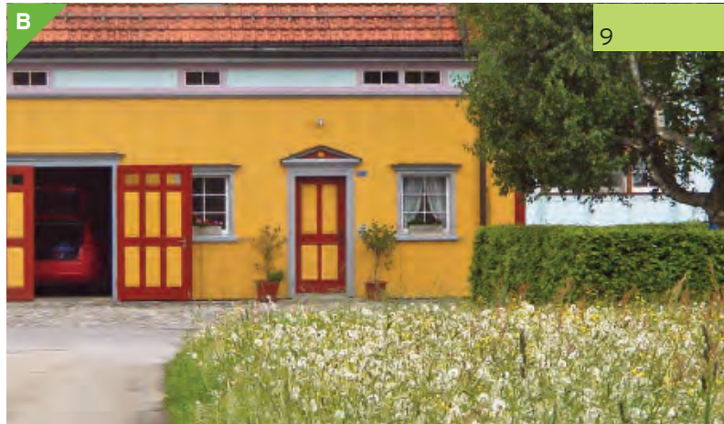
Abb. 19: Die beste Lösung für überdachte Autostellplätze - der ehemalige Stall.
