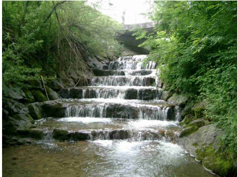
Abb. 10: Absturzgruppe in der Glatt bei km 20.54
