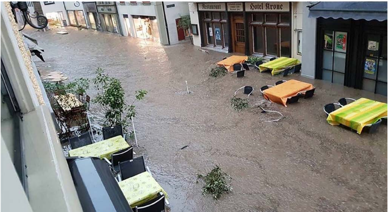
Dieses Hochwasser in der Zofinger Altstadt entstand vorwiegend durch Oberflächenabfluss (Quelle: ZVG).
