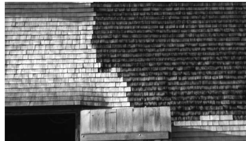
Restaurierte Schindelfassade gegen Nordosten an einem Tätschdachhaus aus dem Jahre 1576 auf Vögelinsegg in Speicher
