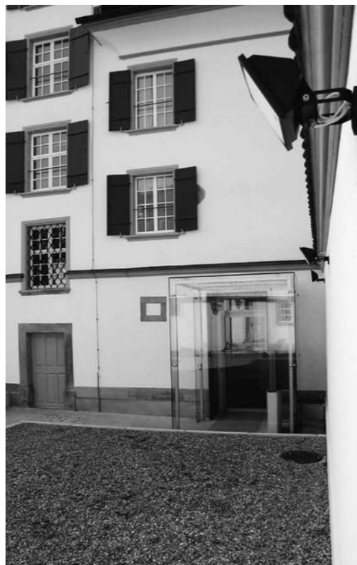
Rückfassade mit neuem Eingang des heutigen Gemeindehauses in Bühler. Projekt Ammann Partner AG
