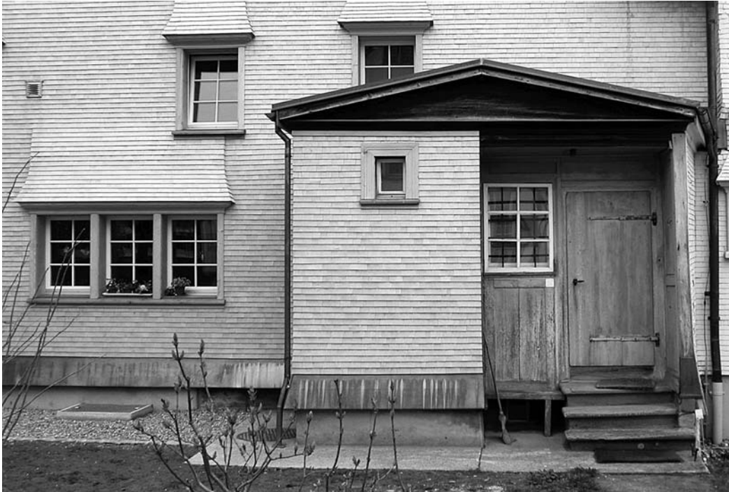
Speicher, Röhrenbrugg, Ass. Nr. 28, Ausschnitt Nordfassade mit Eingang, Baujahr 1686, An- und Umbauten 1756, 1771, 1846, Sanierung 2004.
