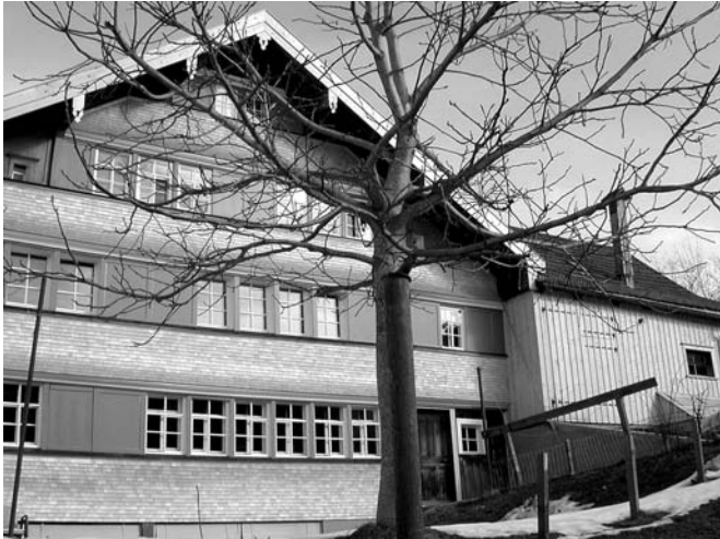
Rehetobel, Gasthof Bären (Urwaldhaus), Ass. Nr. 364, sanierte Hauptfassade.
