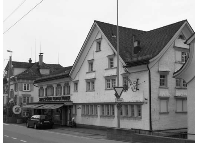
Teufen, geschütztes Ortsbild, Café Spörri, Strassenfassade.
