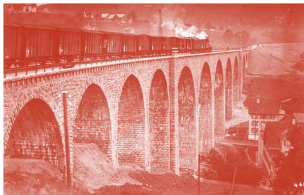
Probefahrt auf dem fertiggestellten Glatttal-Viadukt, Ende September 1910.
