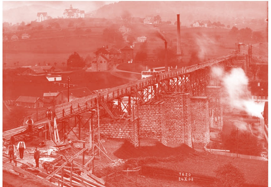
Glatttal-Viadukt: Arbeitsstand am 26. Oktober 1908 und Details der beiden westlichen Bogen am 2. November 1908.
