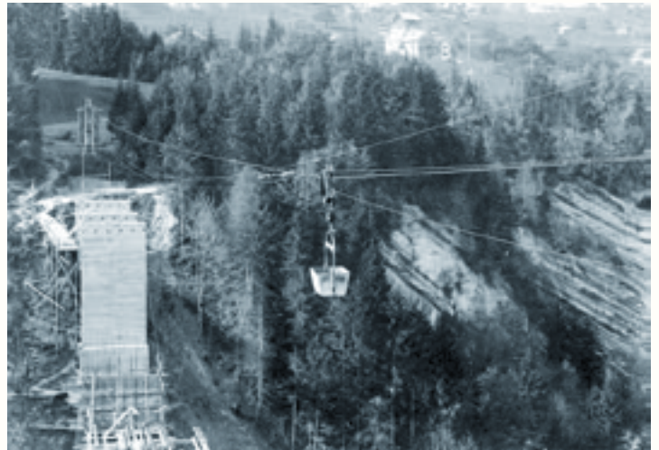
Unten: Transportseilbahn über der Grossbaustelle Gmündertobelbrücke, 1907.
