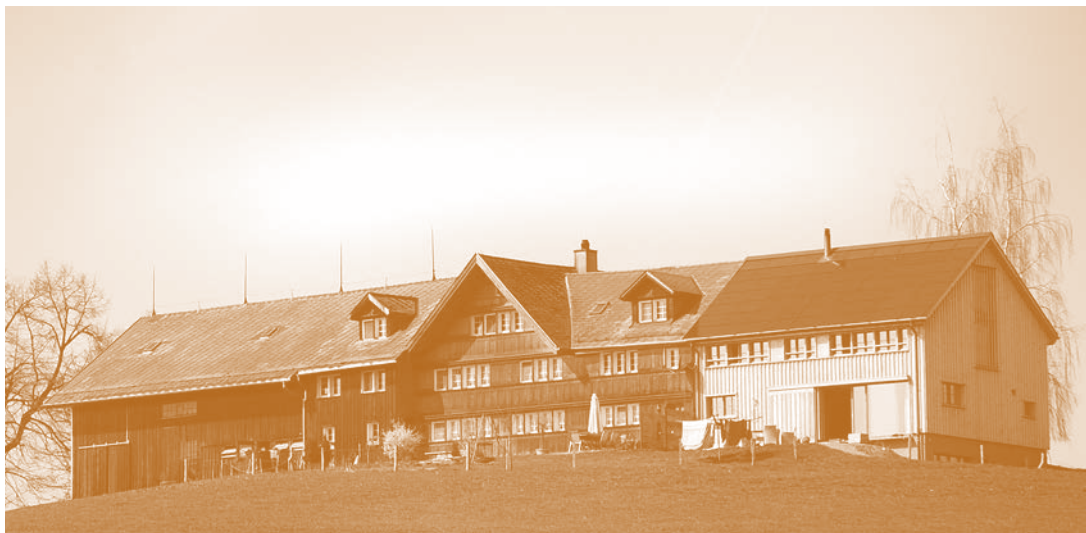
Renovation des Wohnhauses Ufem Berg in Herisau. Umnutzung der Scheune Ost in eine Wohnung.
