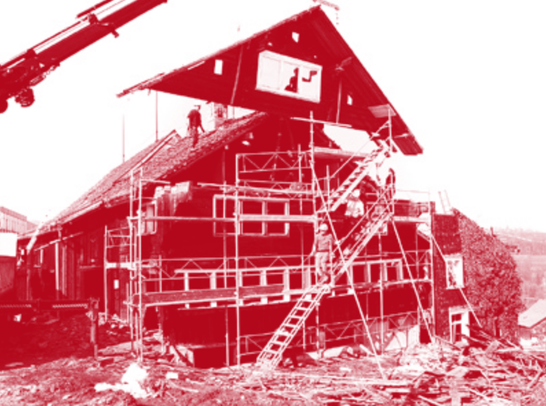
Die 400-jährige Fassade eines Appenzellerhauses am nordöstlichen Dorfrand von Wolfhalden wird abgebaut und in Gais als Schulungsobjekt montiert.
