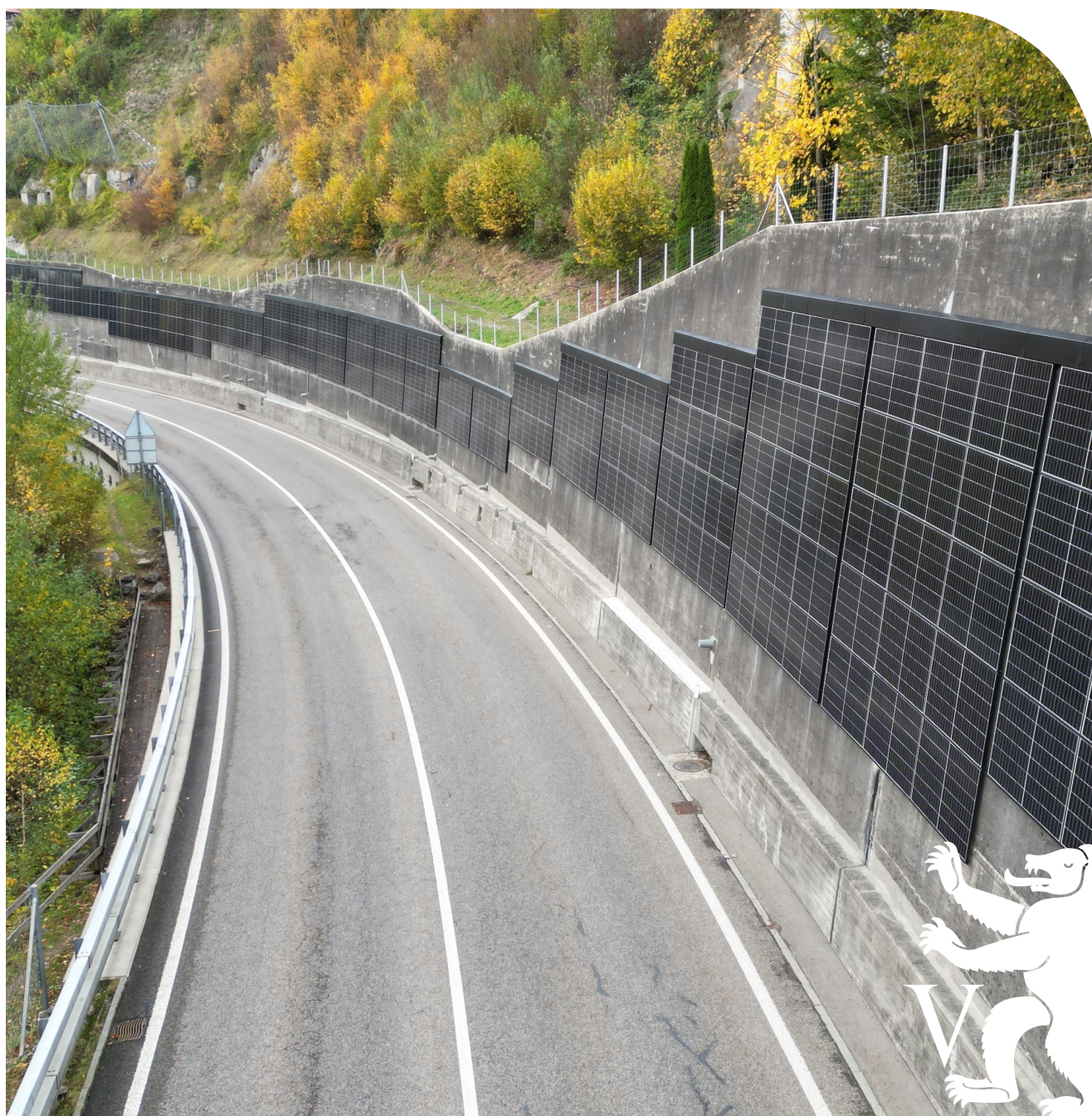
Eine der grössten Photovoltaik-Anlagen im Kanton an der Stützmauer der Umfahrungsstrasse Teufen. Foto: DBV
