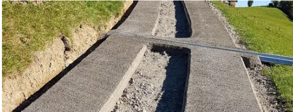
Querrinne in Betonfahrspur zum Schutz des zu bekiesenden Mittelstreifens.
