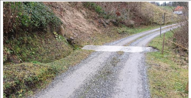
Metallprofil mit Querneigung zur Wasserableitung an steiler Lage.
