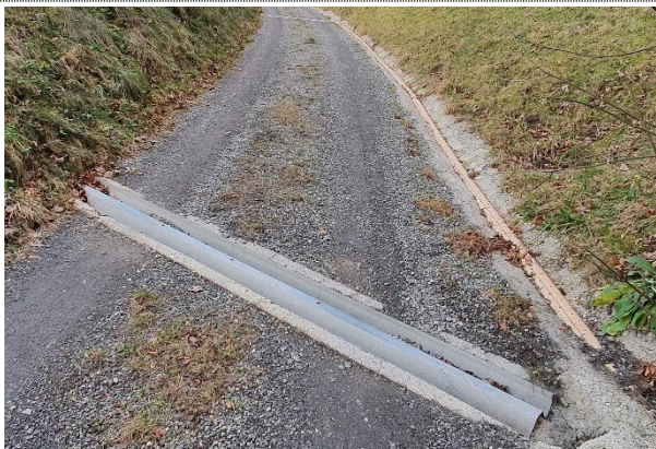
Doppelte Querrinne einbetoniert mit deutlicher Neigung zur sicheren Abführung des Wassers. Zusätzlich seitliche Rinne zur Führung des Wassers in dieser Hohlgrasse.
