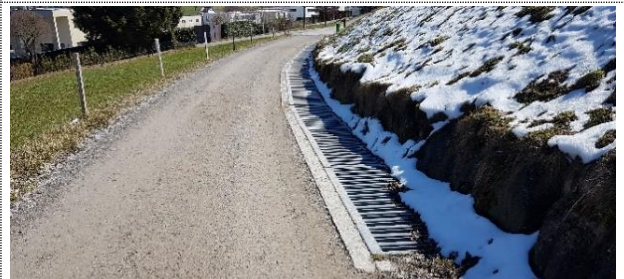
Massive und breite, hangseitige Wasserrinne zur Sammlung von anfallendem Oberflächenwasser.
