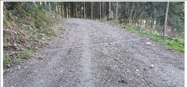
Metallprofil mit Querneigung zur Wasserableitung an steiler Lage.
