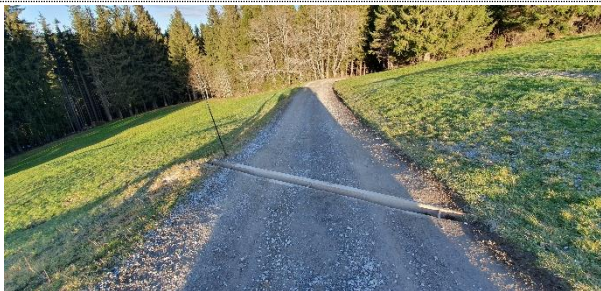
Breite Holzrinne mit ausreichender Neigung zur Wasserableitung und teilweisen Selbstreinigung. Kiesstrasse mit bindigem Material ausgeführt.
