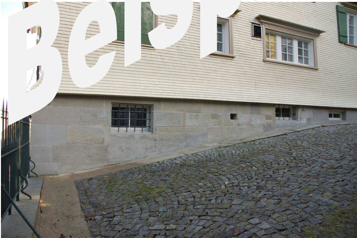
Übergang Sockel-Schindelschirm
