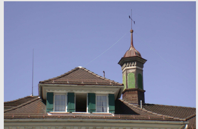
Restaurierter Dachreiter mit Blitzschutz nach dem Umbau 2002. Projekt Arch. Büro Thomas F. Peterer
