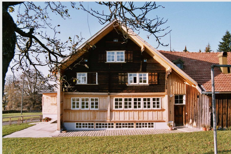
Sanierte Täferfassade an einem Kreuzfirstbauernhaus in Teufen
