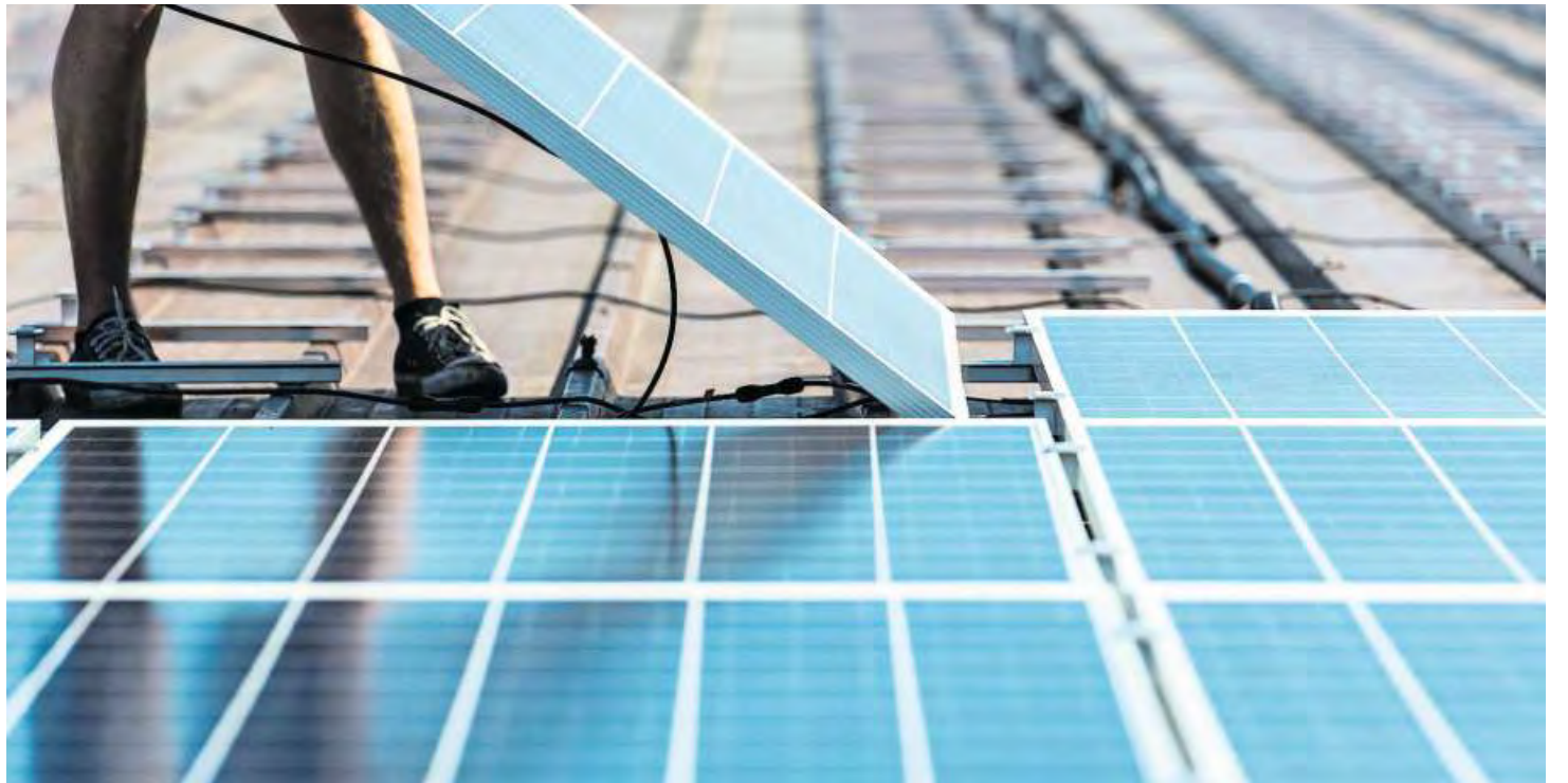
Batteriespeicher für Fotovoltaikanlagen werden neu im kantonalen Förderprogramm bedacht.
